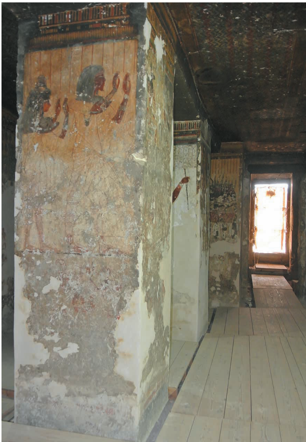
Fig. 6. Vista de la cara central del pilar noroeste (Pereyra 2018).
