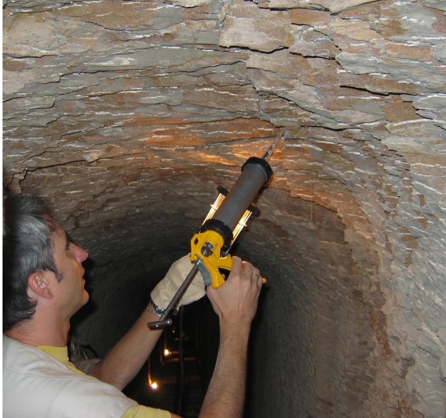
Luis Abad, Arquitecto del Proyecto, consolidando la roca en el interior del corredor 'a'. TT353
