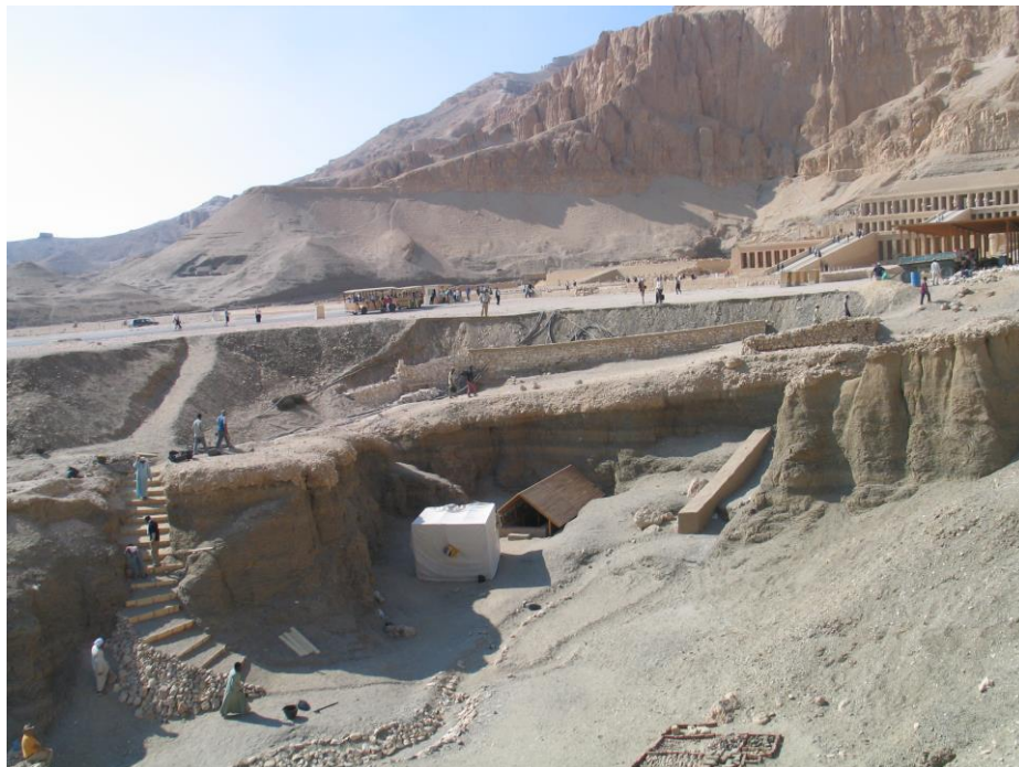
Estado final de las obras de construcción del acceso a ' La Cantera ', desde la calzada del Templo de Hatshepsut
