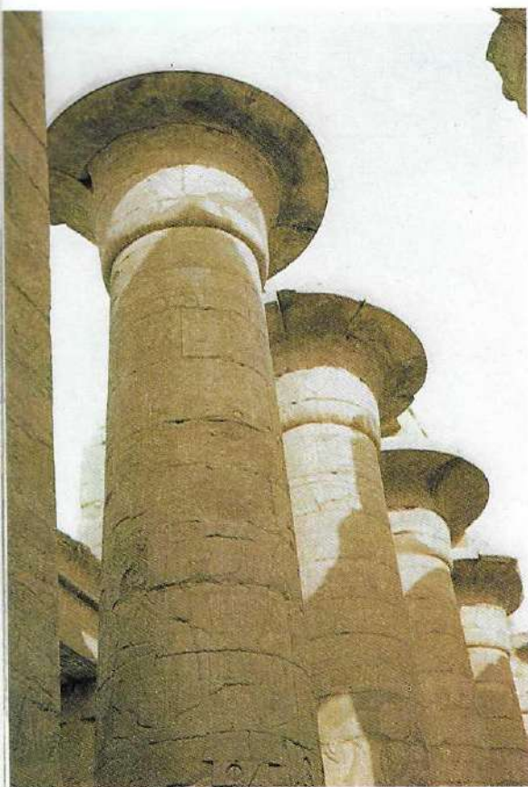
Corredor Central. Perspectiva de la columna.
