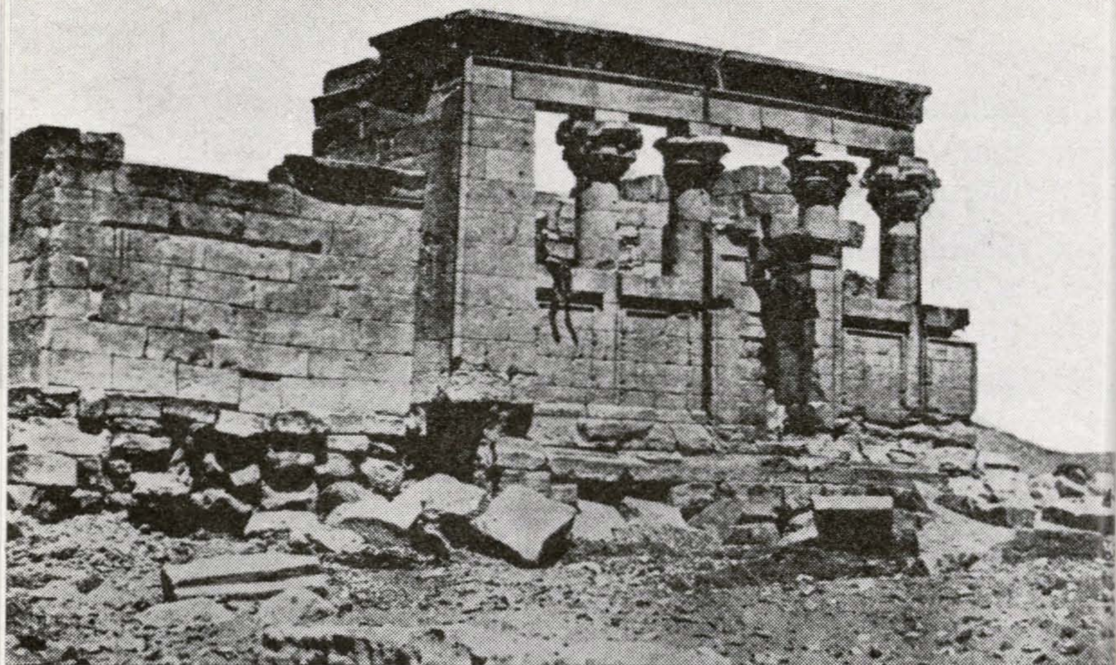
Fig. 5.—La fachada y capilla lateral del templo de Debod según M. Ducamp.
