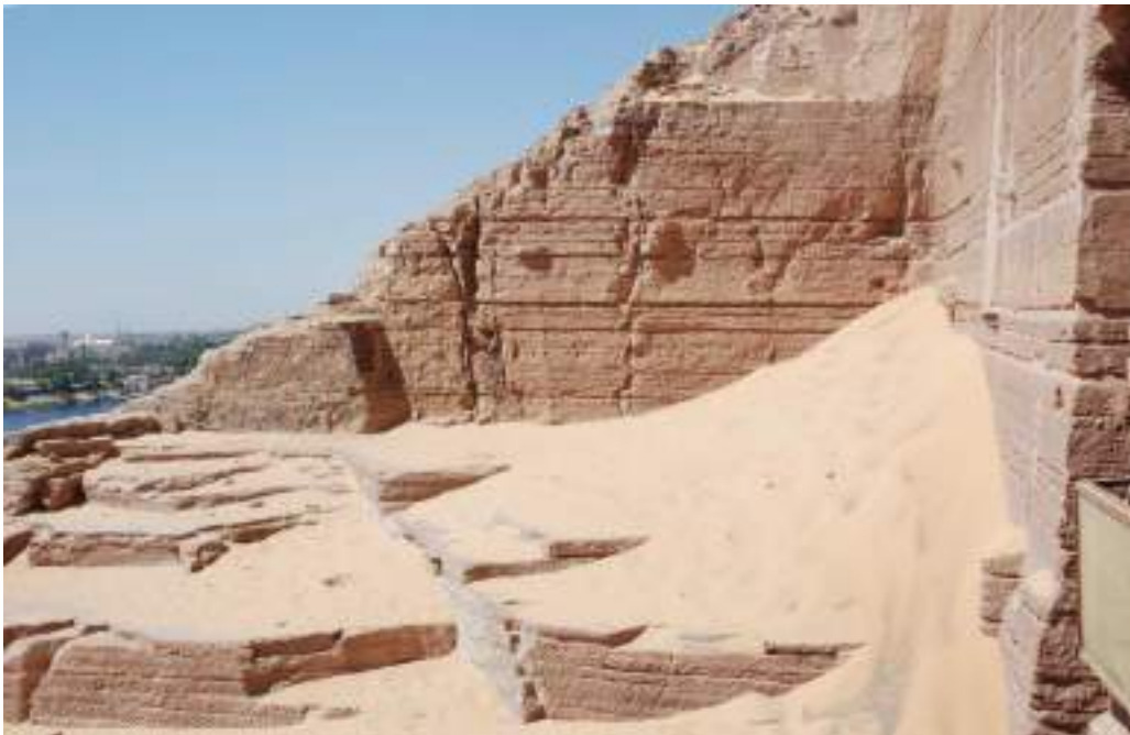
Fig. 5.17. Pared lateral sur del patio exterior de QH31, justo al inicio de los trabajos de la UJA. Autor: I. Mellado García © Proyecto Qubbet el-Hawa (campaña 2008). 78
