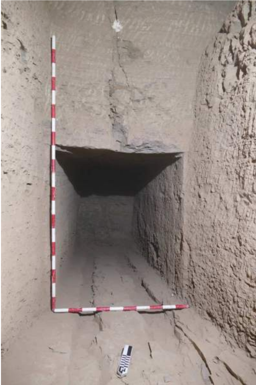
Fig. 9.34. Raíles tallados en el suelo de la cámara sepulcral principal (C2), de la subestructura de QH31. Autor: J.M. Alba Gómez © Proyecto Qubbet el-Hawa (campana 2015).
