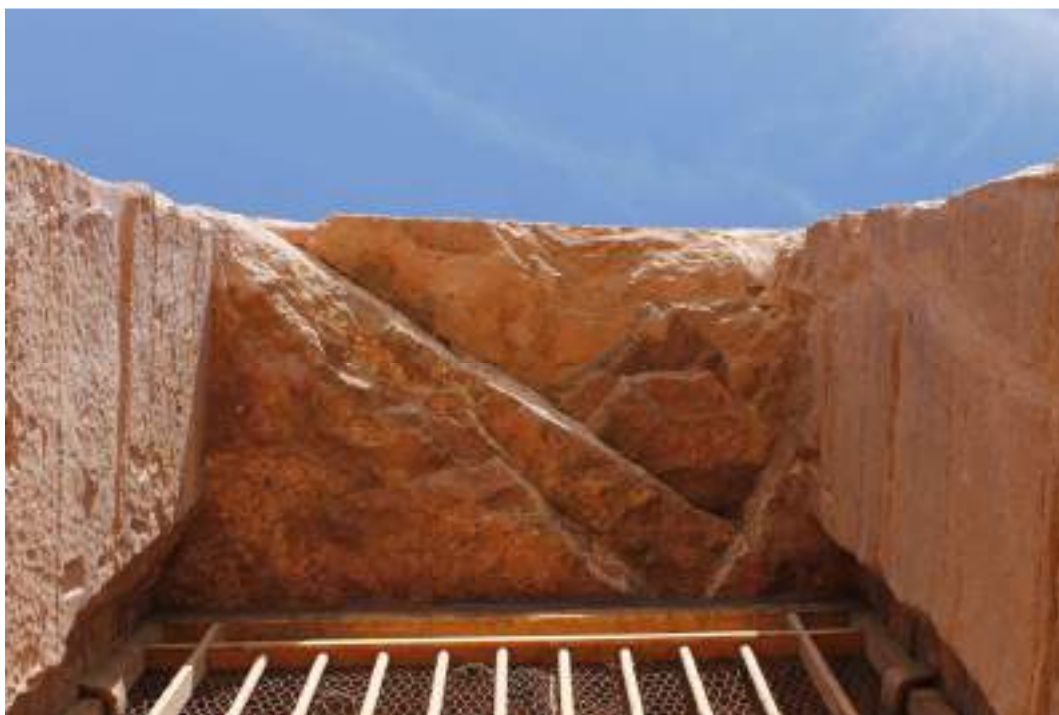
Fig. 5.35. Umbral de la puerta de QH31 parcialmente desprendido (estrato de unos 20 cm., de espesor). Autor: F. Martínez Hermoso © Proyecto Qubbet el-Hawa (campana 2014).
