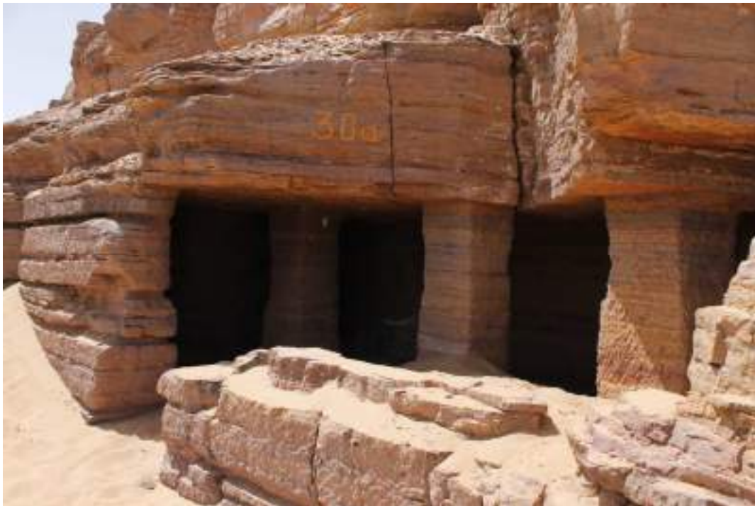
Fig. 4.35. Derrumbe parcial de la fachada del hipogeo QH26a. Autor: anónima © Proyecto Qubbet el-Hawa (campana 2015)
