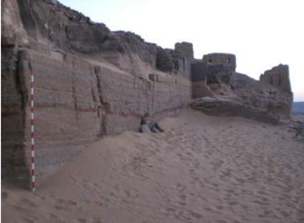
Fig. 5.9. Patio exterior del hipogeo QH33, justo al inicio de los trabajos de la UJA. Autor: Autor: J.L. Martínez de Dios © Proyecto Qubbet el-Hawa (campana 2008).
