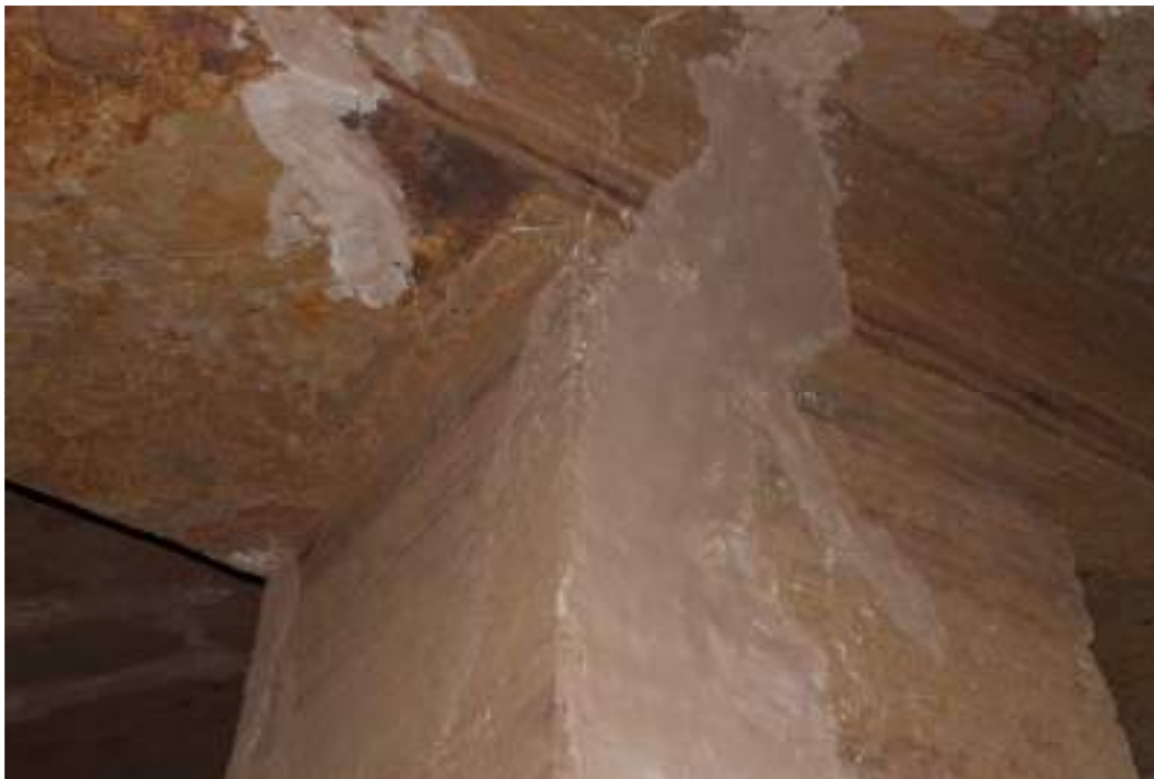
Fig. 6.24. Reducción de la parte superior de la cara trasera de un pilar del pórtico sur de la sala hipóstila de QH31. Autor: F. Martínez Hermoso © Proyecto Qubbet el-Hawa (campana 2014).
