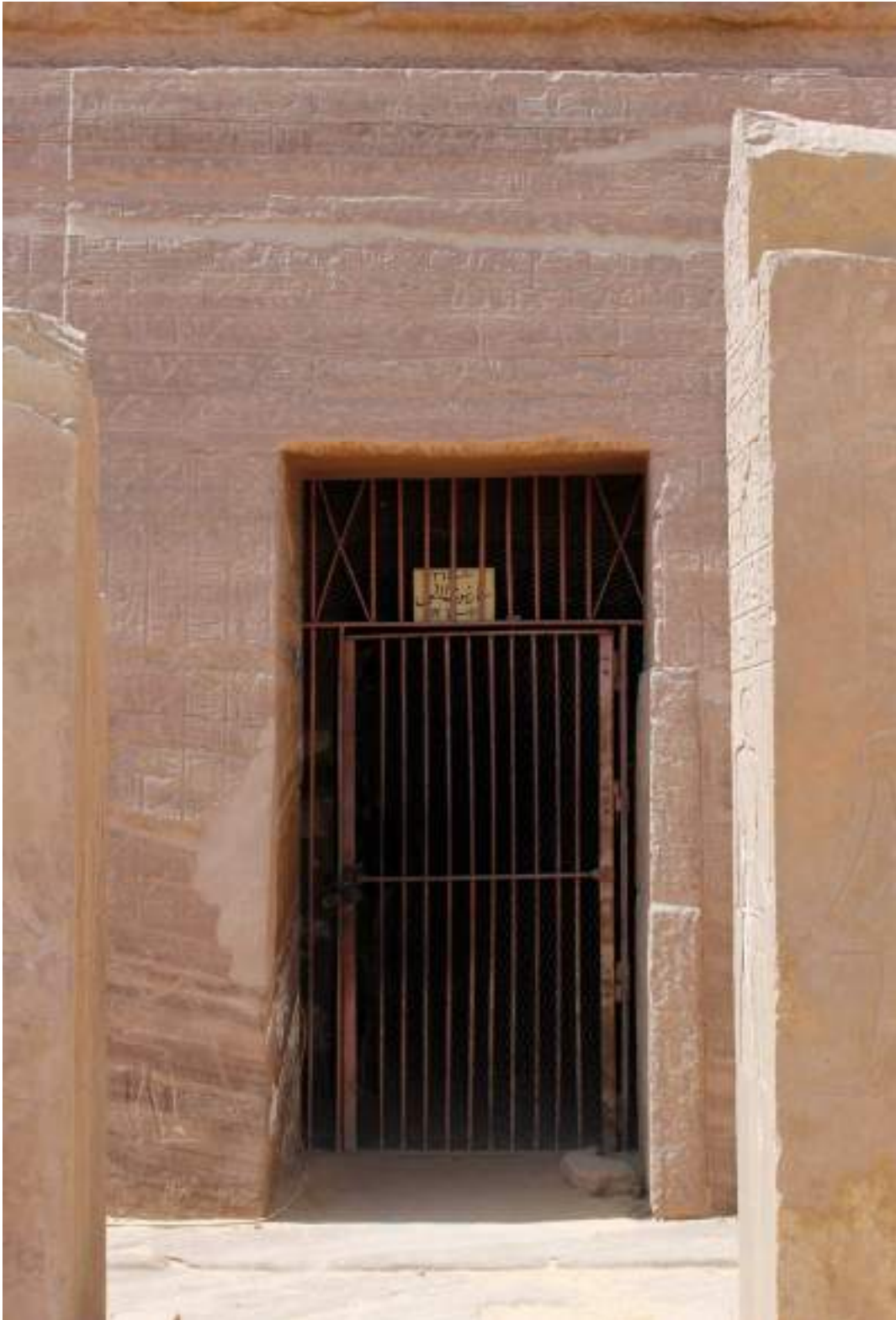
Fig. 5.31. Puerta de entrada a la capilla del complejo funerario QH36 (Sarenput I). Autor: F. Martínez Hermoso © Proyecto Qubbet el-Hawa (campana 2014).
